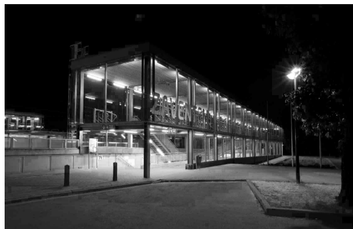
1. Kantoorstoren Gent Sint-Pieters, Poponcini en Lootens ir. Architecten 2. House NA, Sou Fujimoto 3. Voetgangersbrug E40 4. Uitbreiding Brigitinnekerk, SumProject en Andrea Bruno 5. Station Zaventem
